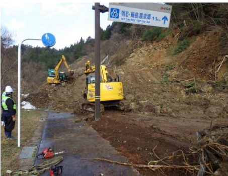
輪島市三井町地内 道路啓開
