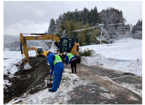
輪島市町野町金蔵地内 道路啓開
