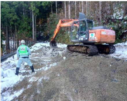
輪島市門前町平地内 道路啓開
