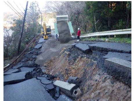
鳳珠郡穴水町川尻地内 道路啓開
