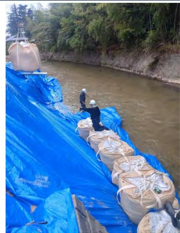
北茨城市での大雨による堤防決壊や土砂崩れのための応急復旧作業
