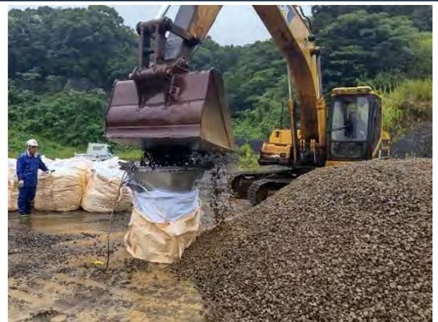
長崎県松浦市での豪雨による法面崩壊に伴う応急復旧作業
