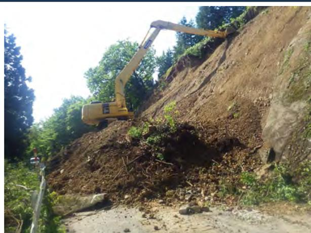
法面一部崩壊、土砂流入の応急復旧作業
