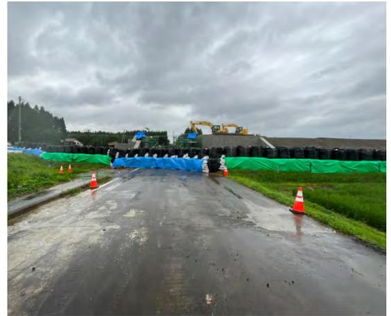
秋田県内の大雨による堤防決壊等にかかる応急復旧作業
