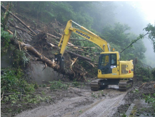
北杜藤見線の土砂崩落による応急復旧作業 （一社）山梨県建設業協会
