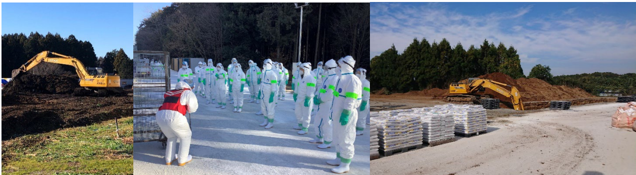
【鳥インフルエンザ】城里町の養鶏場の防疫措置での埋却箇所掘削及び埋却作業
