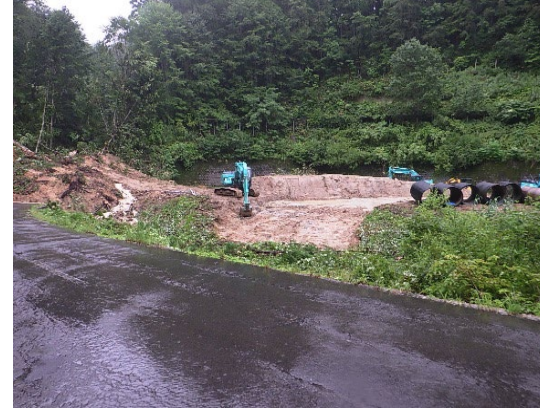
国道105号線土砂撤去、仮設道路設置 （一社）秋田県建設業協会
