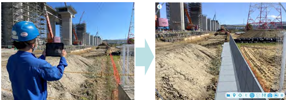
AR（拡張現実）技術により、タブレット画面に完成形を重ね合わせ
