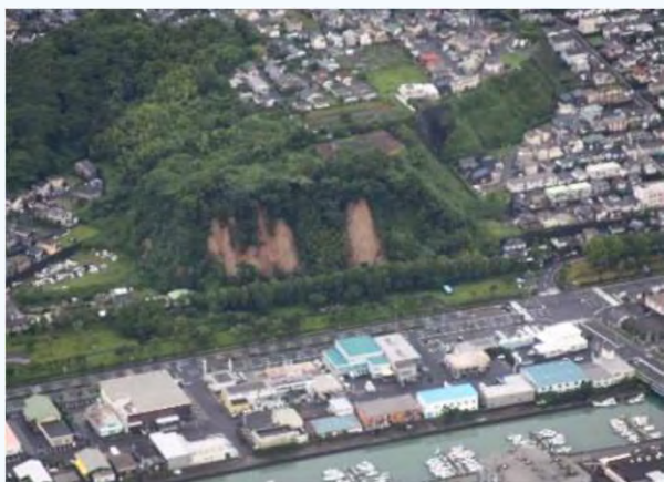
土砂災害の状況（鹿児島市）
