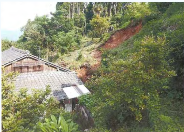
土砂災害の状況（鹿児島県南さつま市）
