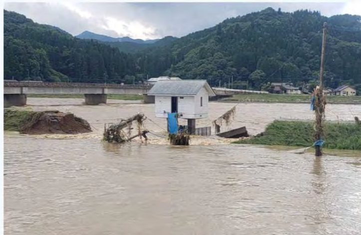
堤防決壊の状況（熊本県人吉市・球磨川）
