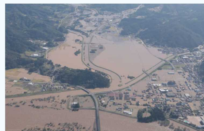
堤防決壊の状況（宮城県丸森町・五福谷川）
