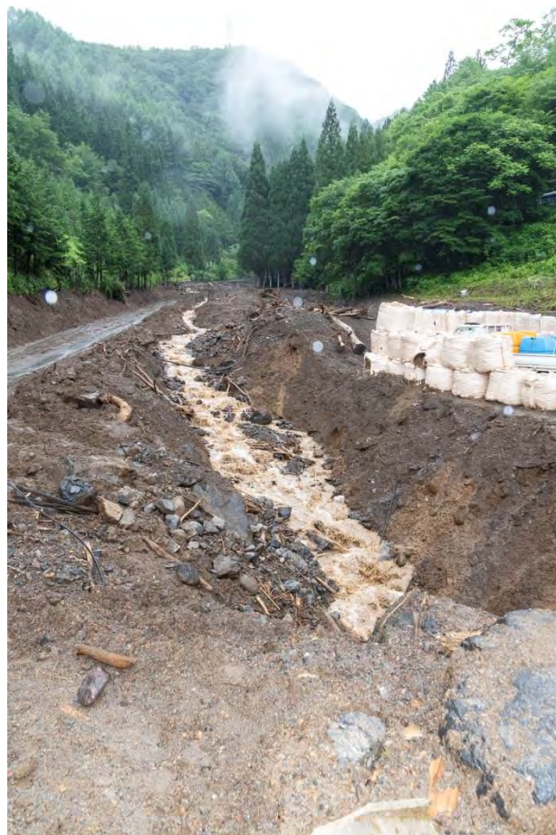
(斜面崩落現場)
