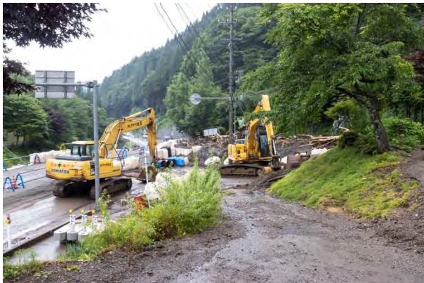
(復旧作業状況)
