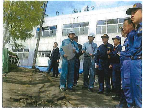
被災現況説明②（左手前は隆起したコンクリート）
