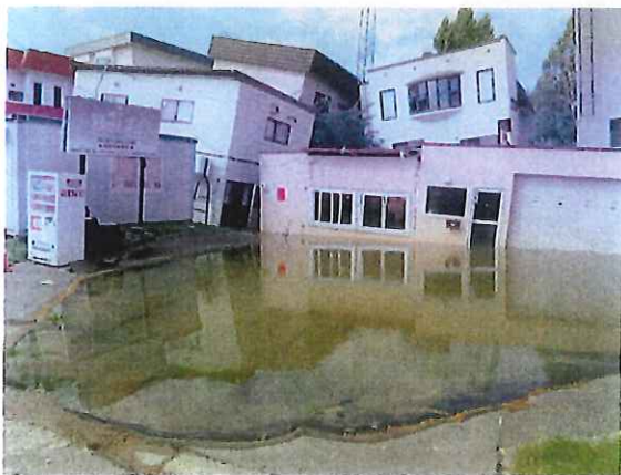
液状化が発生した現場
