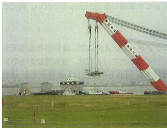
取り外された橋梁
