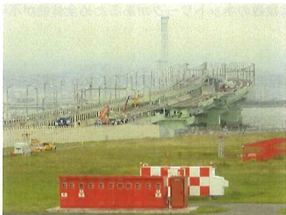
被害を受けた連絡橋
