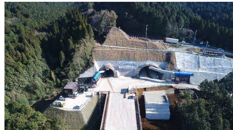
大津側坑口(右:本坑、左:避難坑)
