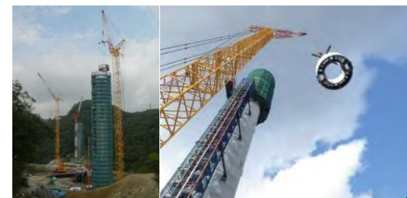
クレーンで吊り込み設置
