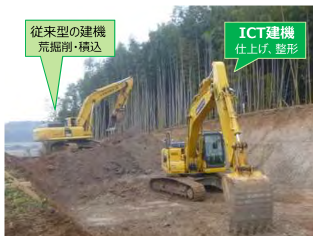
現地状況等に応じて、ICTと従来型の建機を使用
