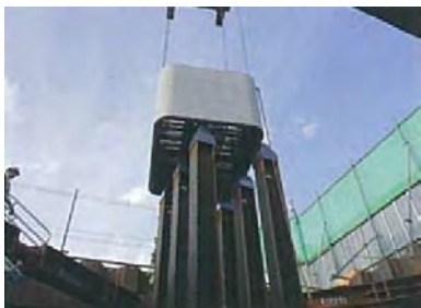
橋梁下部工 橋脚部の埋設型枠
