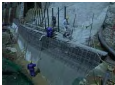
擁壁工 外壁の埋設型枠
