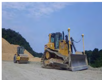
MCブルドーザ敷均し
