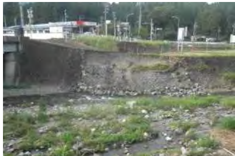
河岸の欠壊に対し、拡大防止のために大型土のうで応急工事を実施
