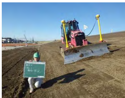
MCブルドーザ法面整形
