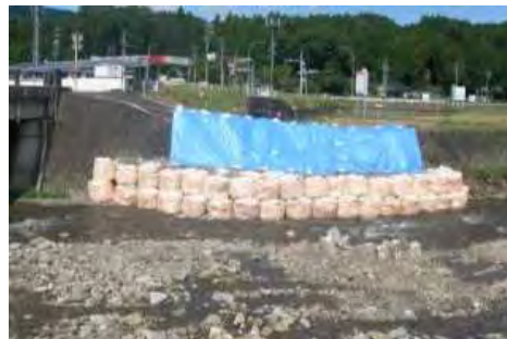
河岸の欠壊に対し、拡大防止のために大型土のうで応急工事を実施
