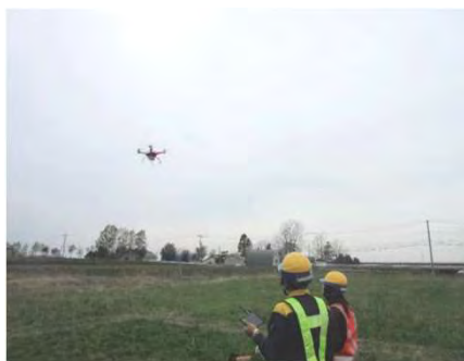
UAVによる施工前の測量
