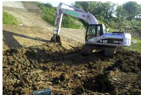
○ ICTバックホウによる法面整形
