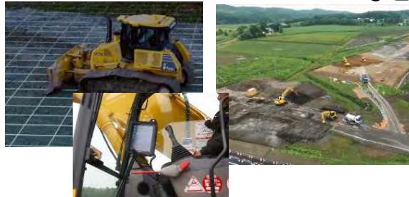
ICT建機での施工
