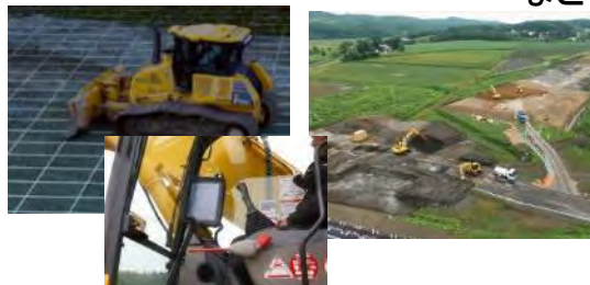
ICT建機での施工
