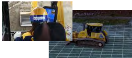
ICT建機による施工
